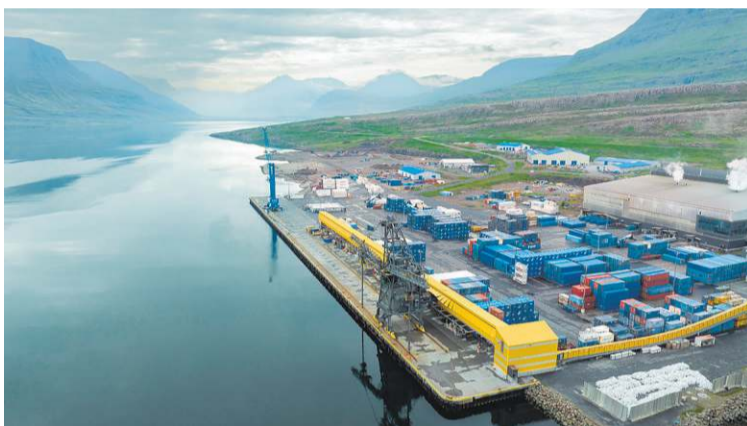
■ Stöðug umferð flutningaskipa er um Mjóeyrarhöfn og næsta stóra framkvæmd Fjarðabyggðarhafna er lenging hafnarkantsins.
