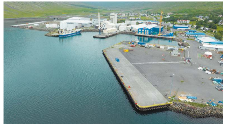
■ Þrjár af fimm aflaghestu höfnum landsins eru í Fjarðabyggð og Eskifjarðarhöfn er ein þeirra. Þar er verið að ljúka framkvæmdum við bryggju í tengslum við nýtt uppsjávarhús og frystigeymslu Eskju.
