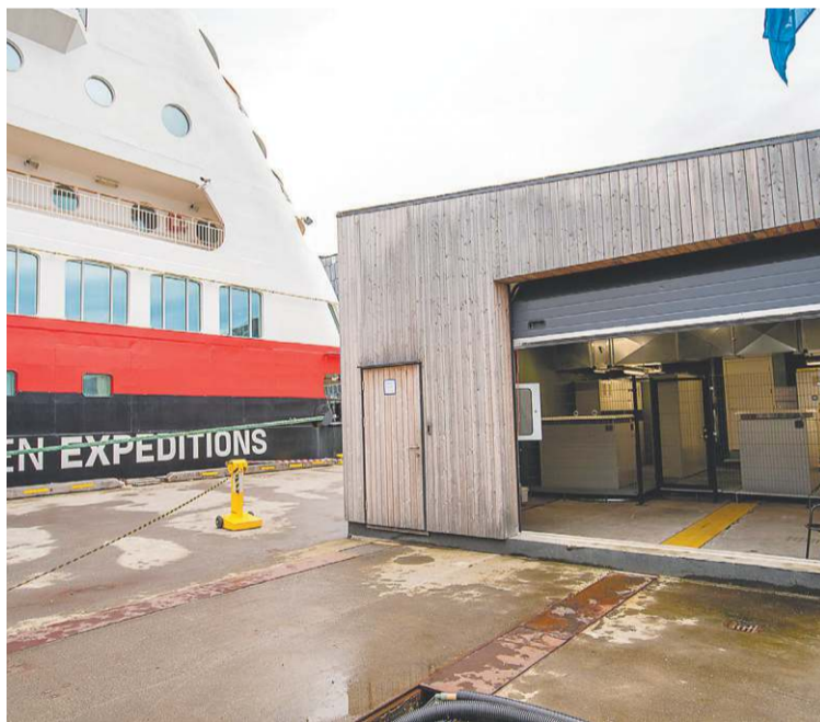
■ Þjónustuhús fyrir landtenginguna á Faxagarði. Batterið Arkitektar hannaði húsið en Verkís sá um verkfræðihönnun þess.
