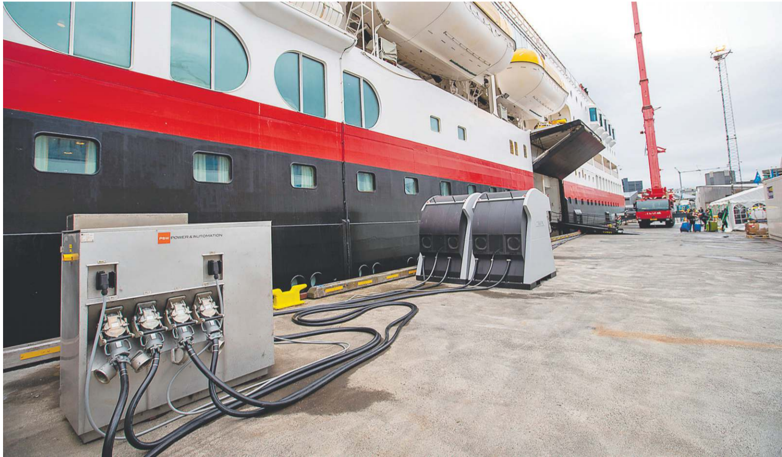
■ Raftengingarbúnaður við skipshlið á Faxagarði í gömlu höfninni í Reykjavík. Búnaðurinn var tekinn í notkun í september og þar með var fyrsta skemmtiferðaskipið landtengt rafmagn í Reykjavík.
