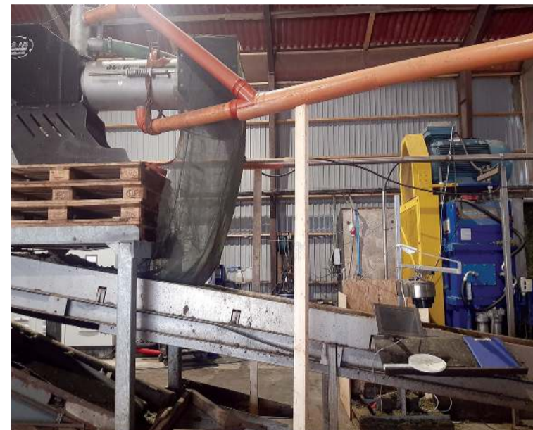
Séð inn í verksmiðjunna.
